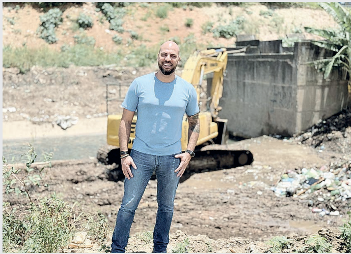
O deputado esteve pessoalmente no local, conferindo a execução dos trabalhos
